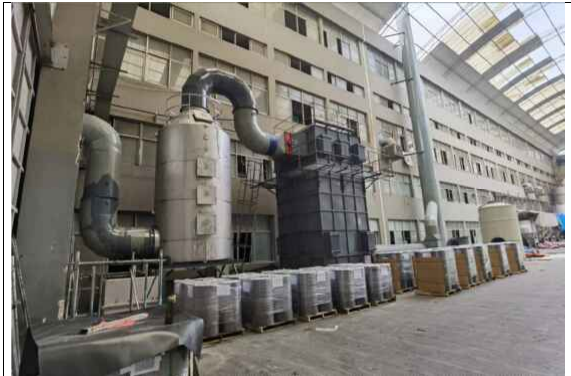
4#废气处理设施（水喷淋+高压静电）
