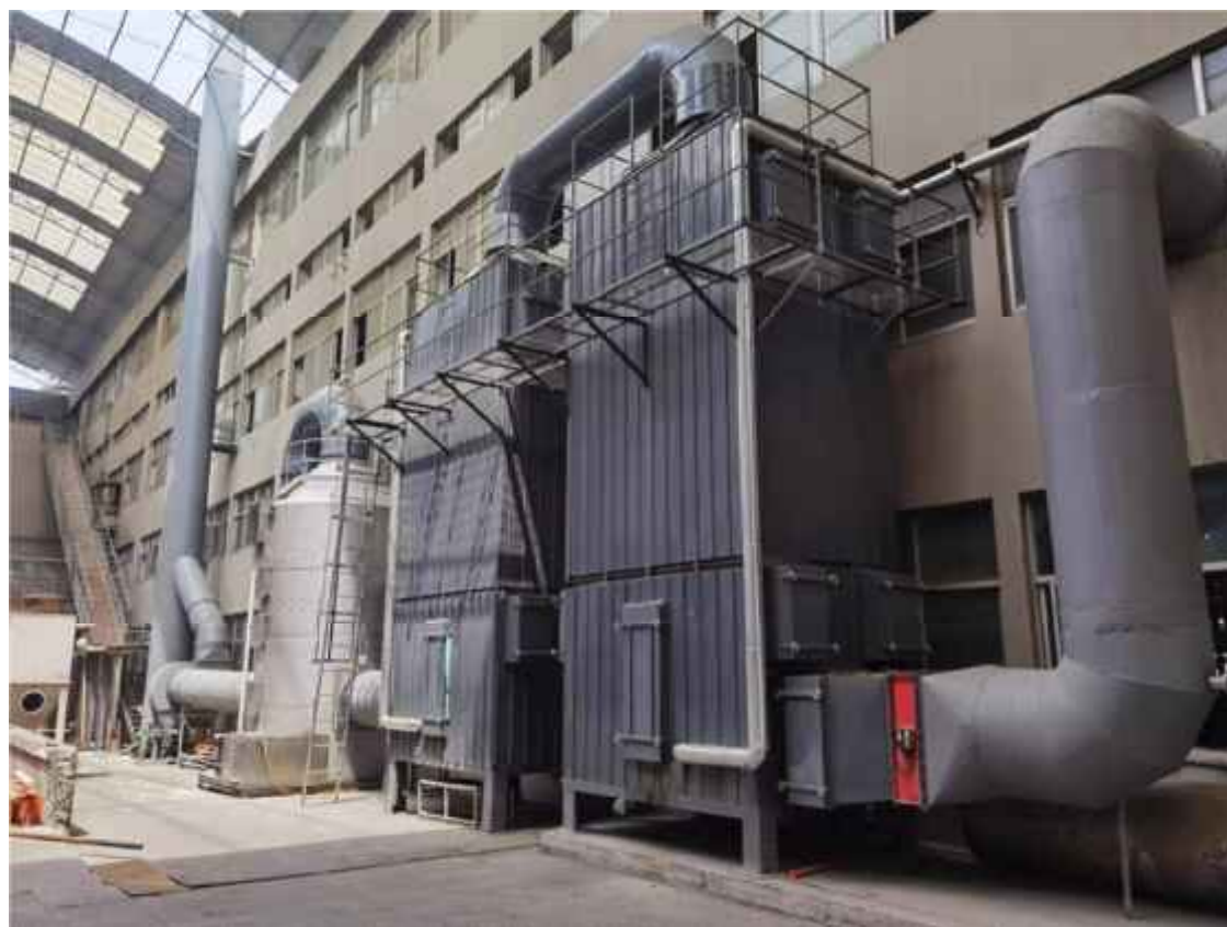
3#废气处理设施（高压静电+水喷淋）
