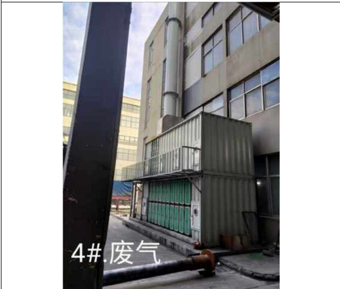
4#废气处理设施（改造前）
