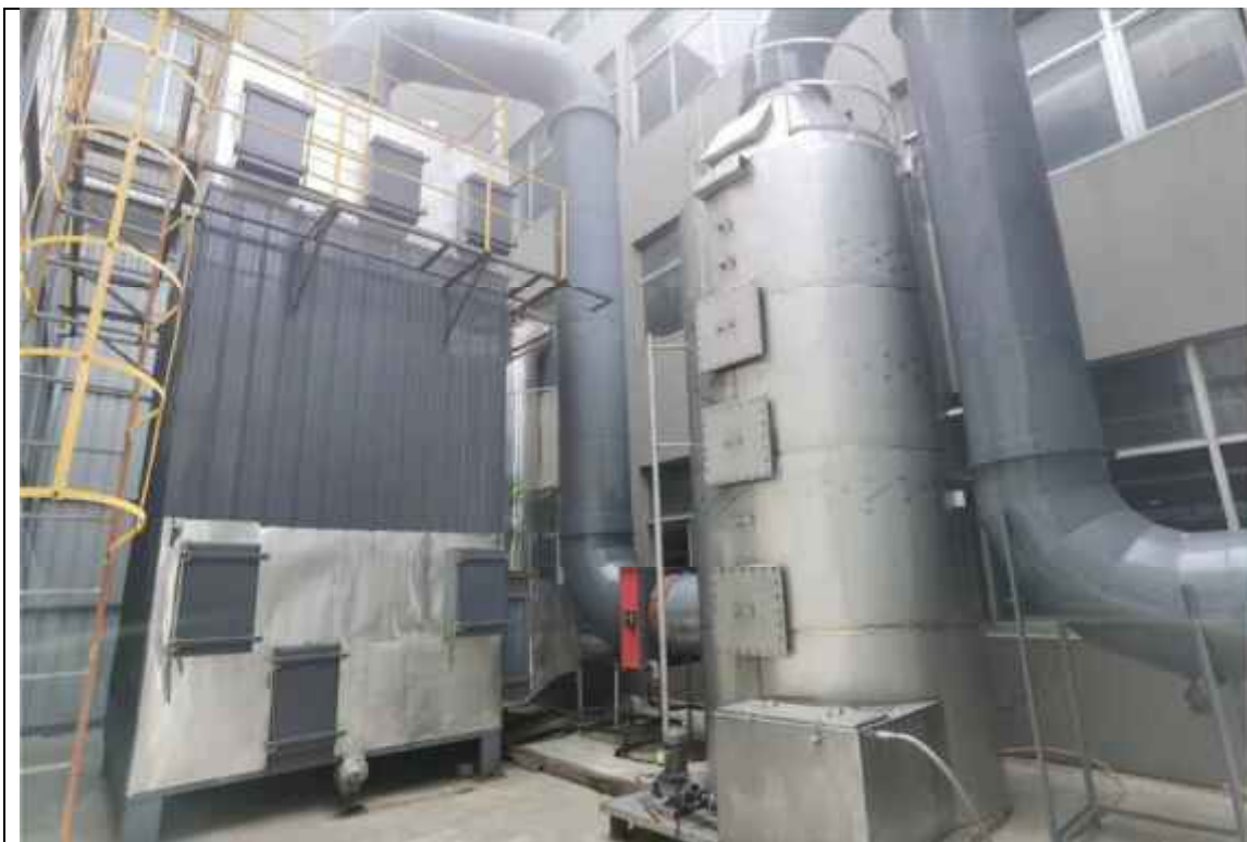
2#废气处理设施（高压静电+水喷淋）
