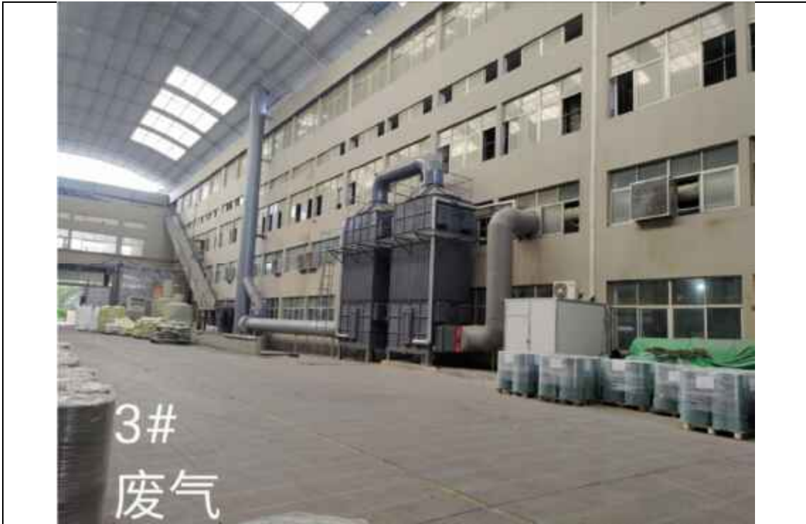
3#废气处理设施（改造前）
