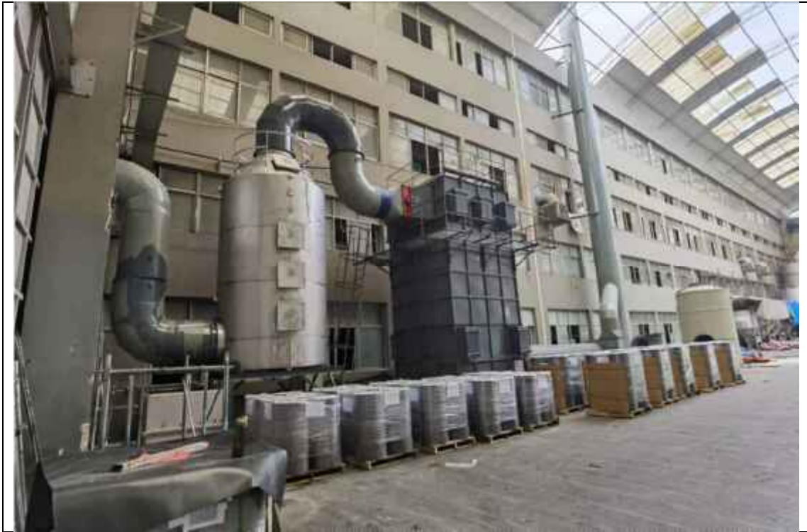
4#废气处理设施（水喷淋+高压静电）
