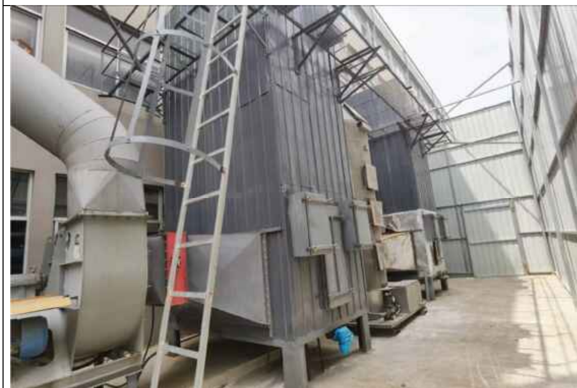
1#废气处理设施（高压静电+水喷淋+高压静电）
