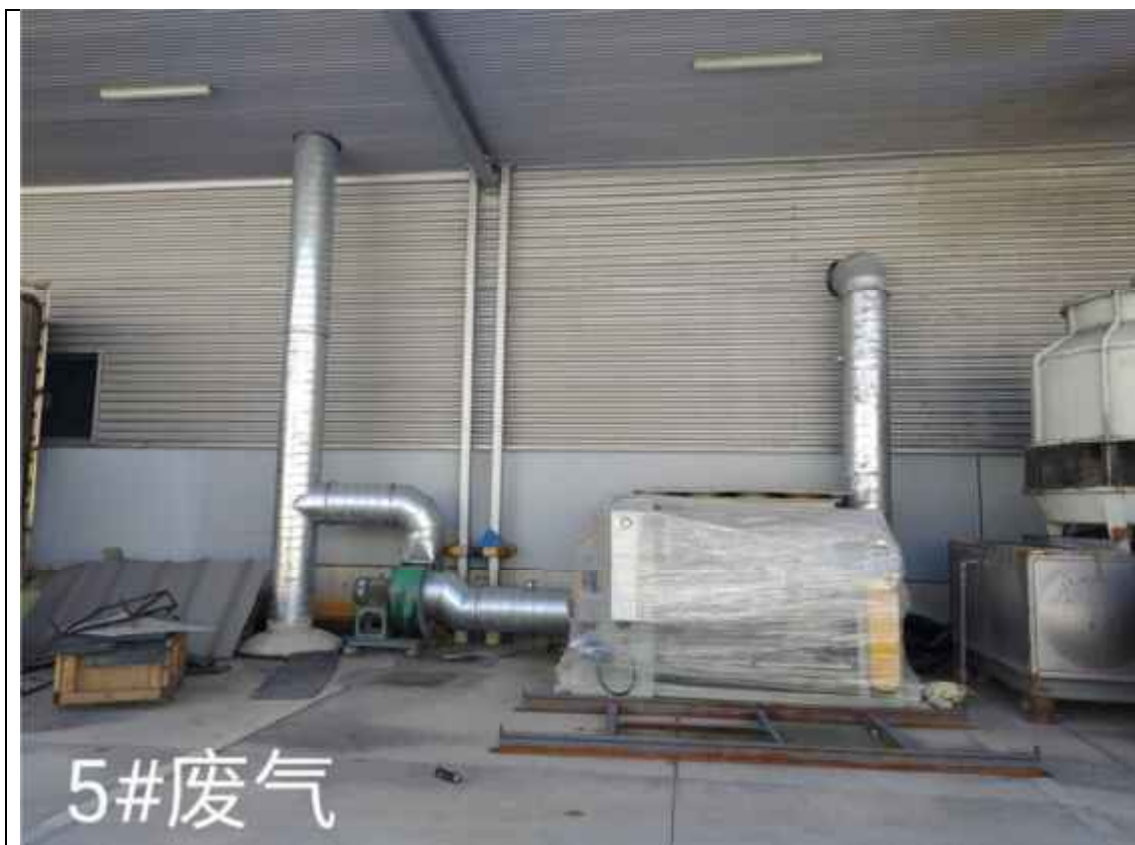
5#废气处理设施
