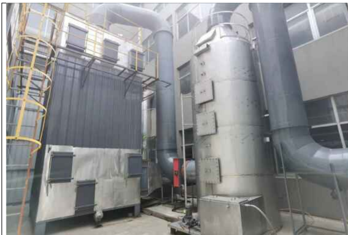
2#废气处理设施（高压静电+水喷淋）
