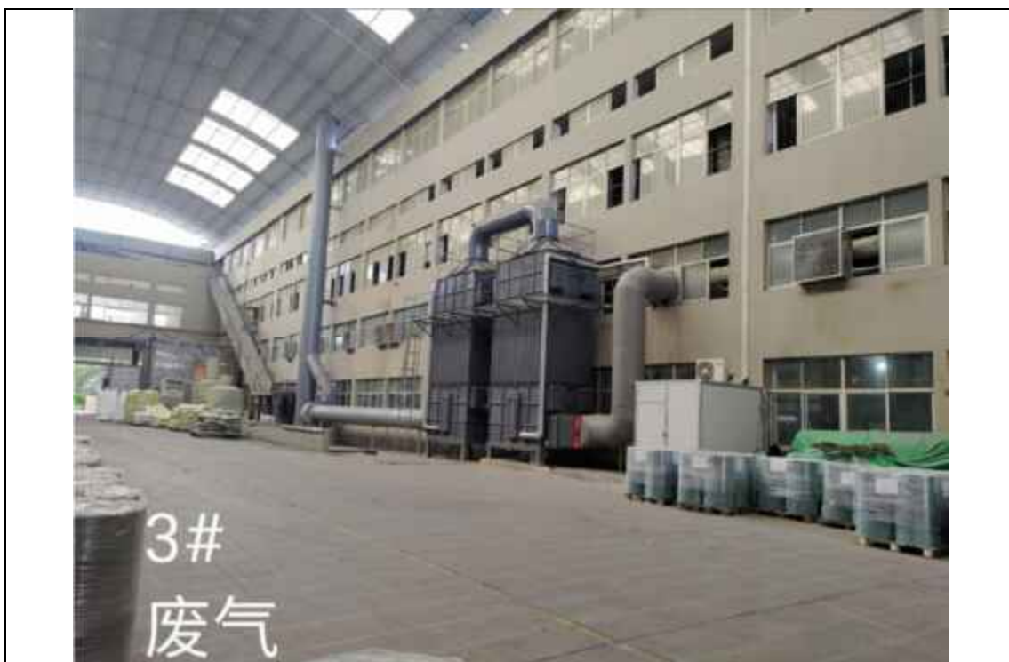
3#废气处理设施（改造前）
