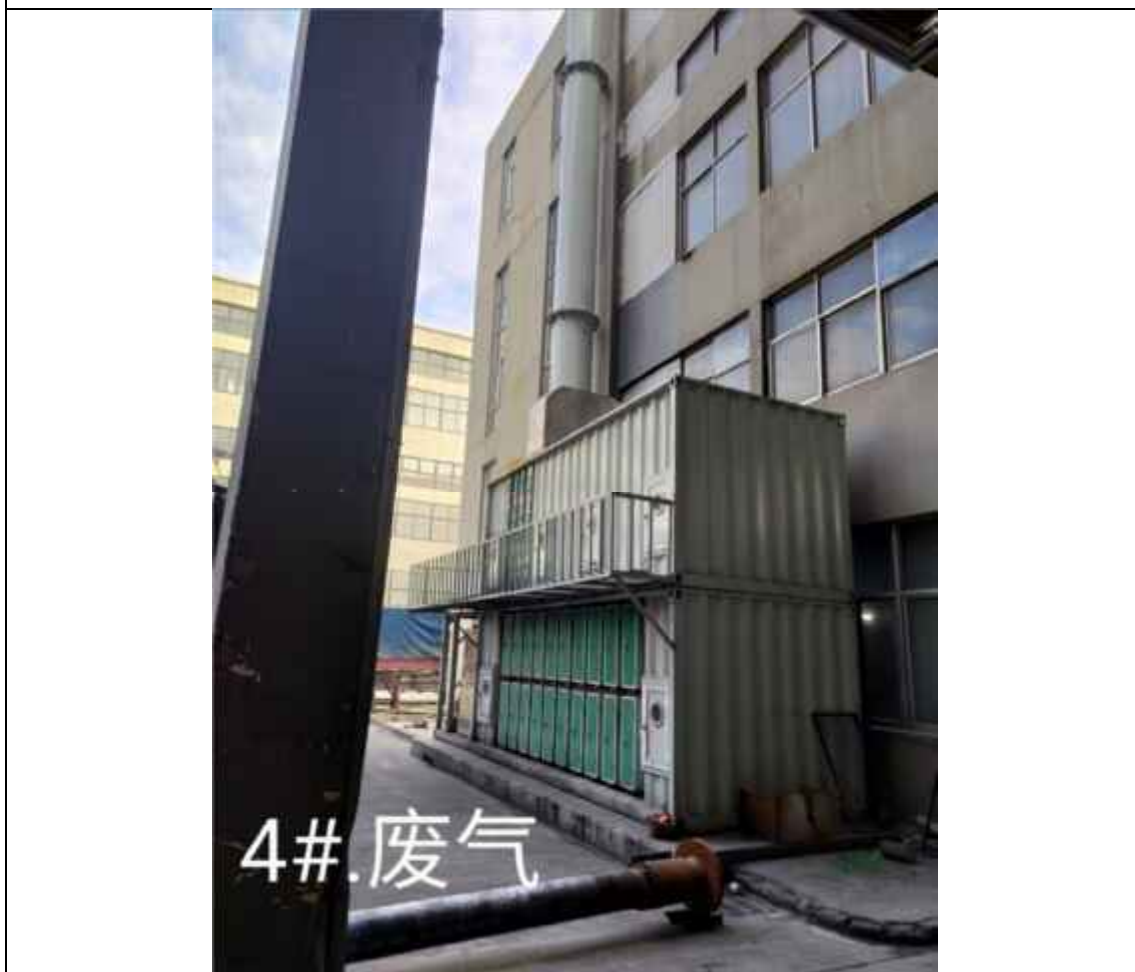
4#废气处理设施（改造前）
