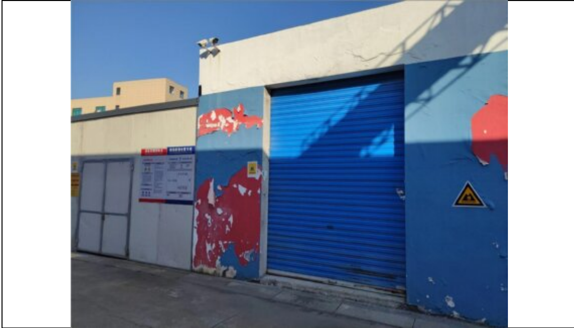
危废仓库外部
