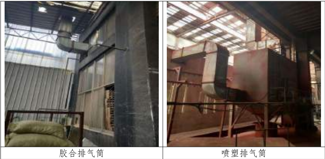
图 4-6 企业废气治理现场相关照片
