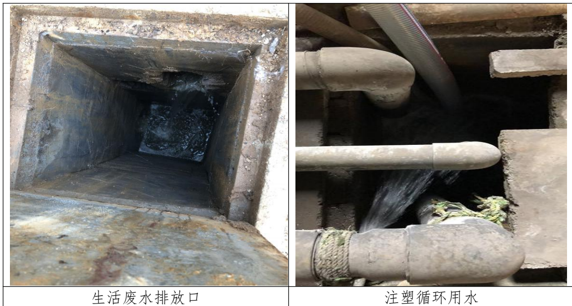
图 4-1 企业废水治理现场相关照片
