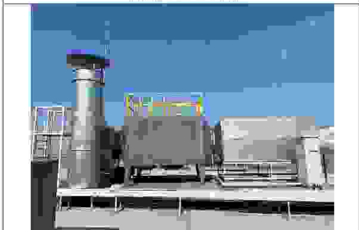
附錄 1 三豐炭礦開採設備
