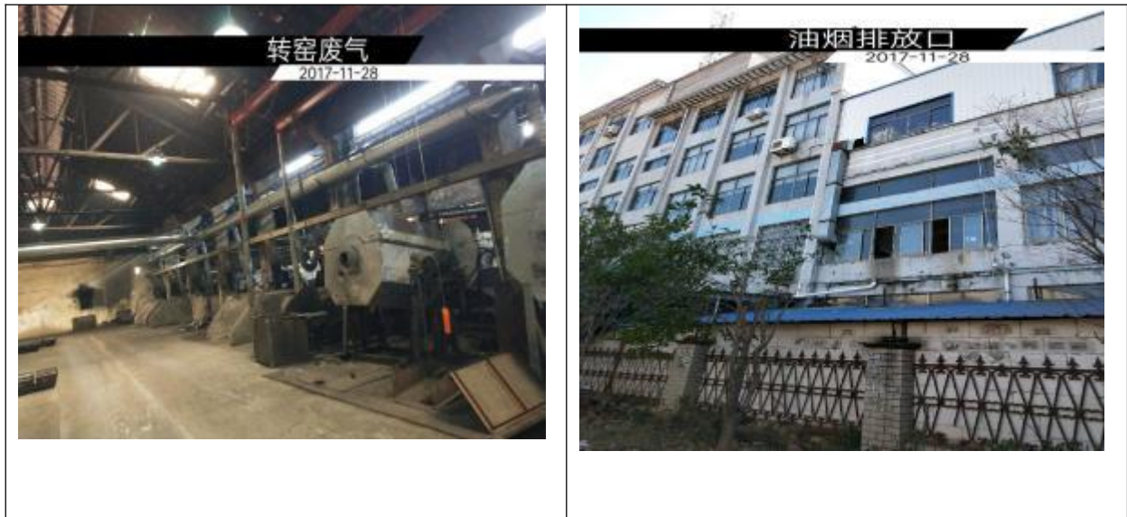
图 4-4 企业废气治理现场相关照片
