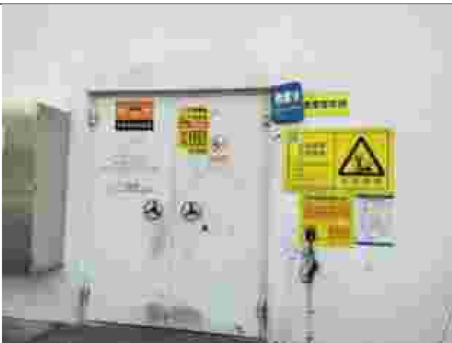
危废仓库外部照片
