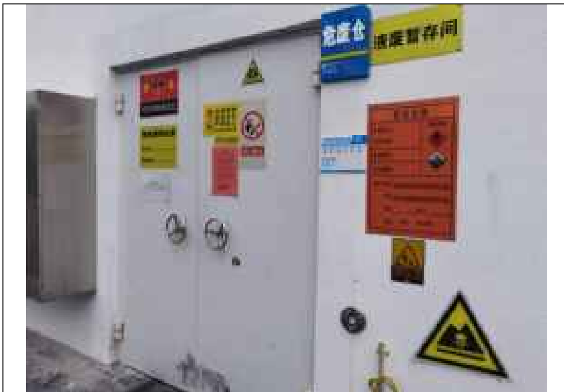
危废仓库外部照片
