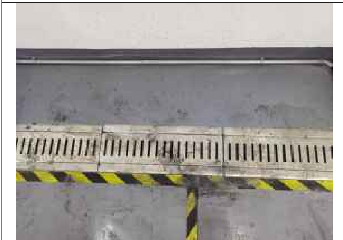
危废仓库内部
