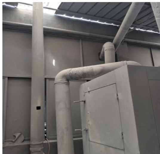
喷砂废气排气筒出口
