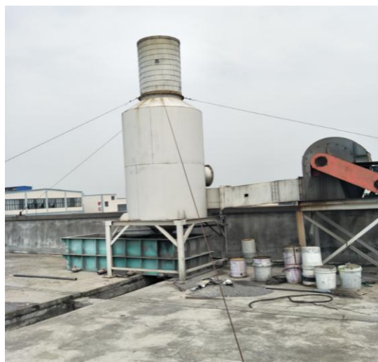
抛光废气排气筒出口
