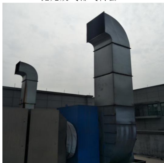
喷漆废气排气筒出口
