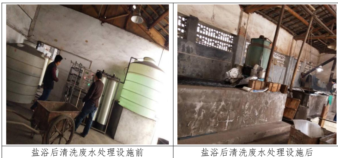
图 4-2 企业废水治理现场相关照片
