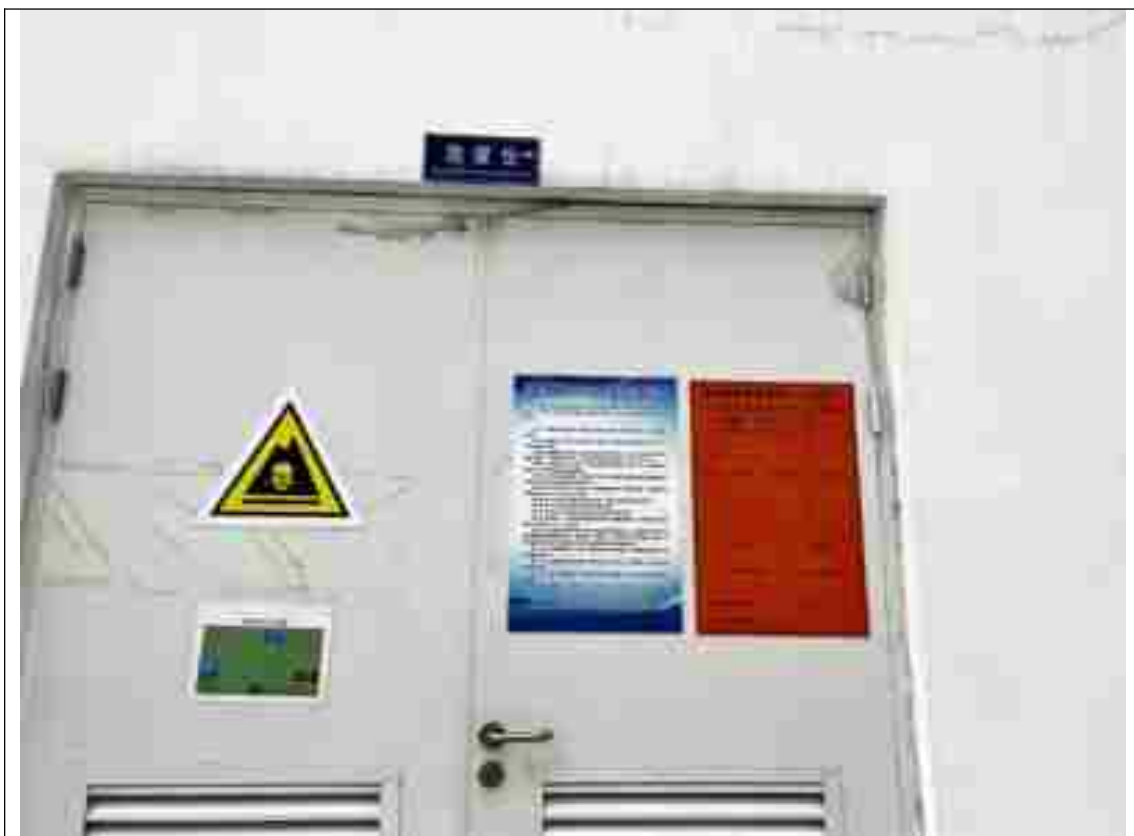
危废仓库外部
