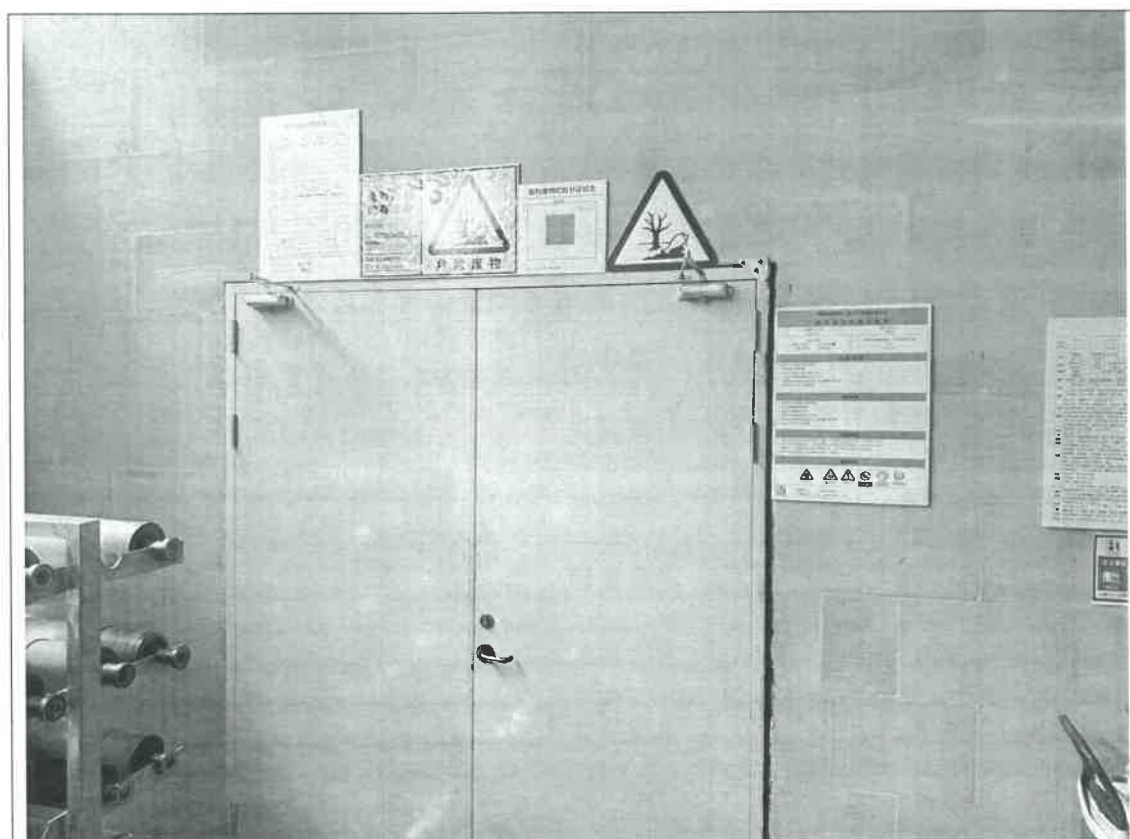
危废仓库外部
