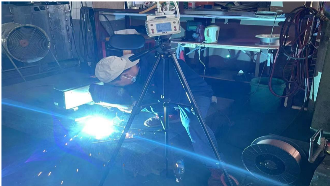
生产车间电焊岗位
