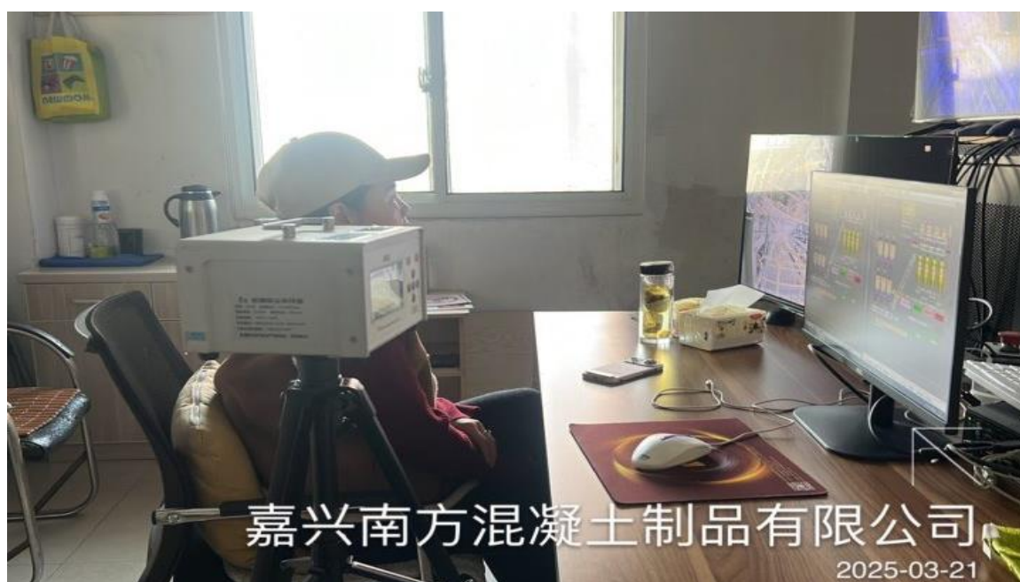
搅拌楼上料控制室岗位
