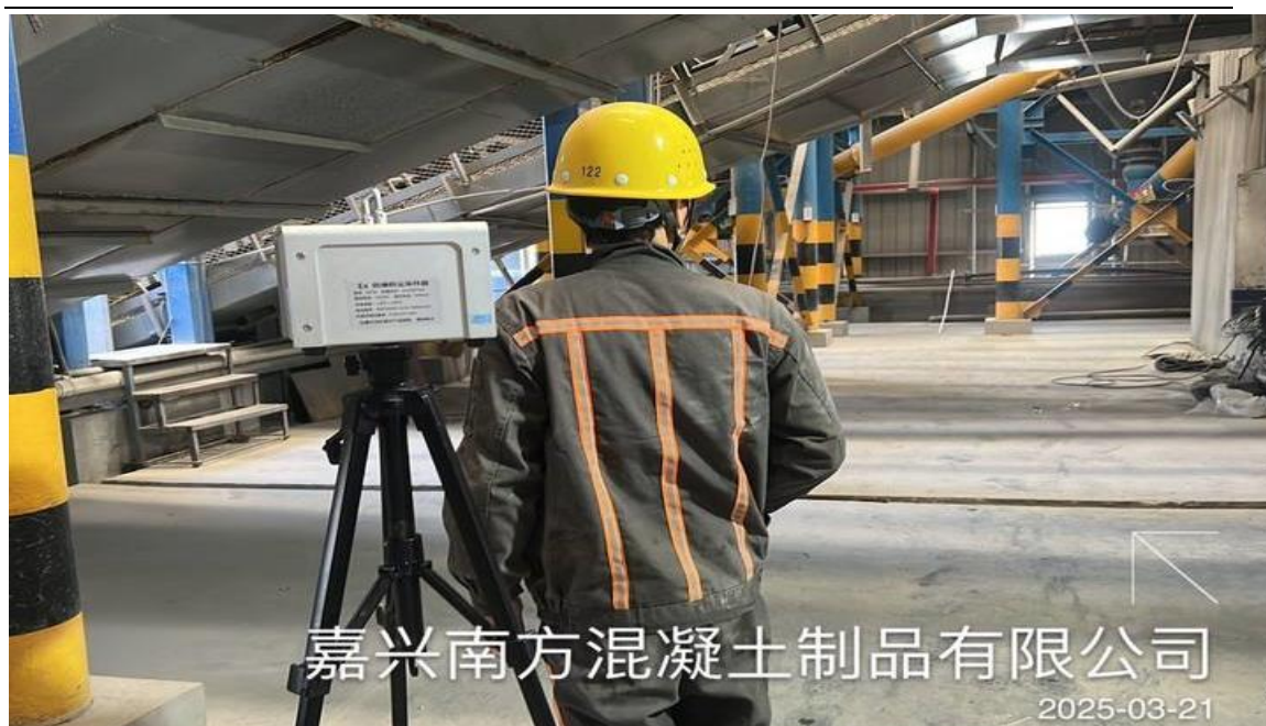
搅拌楼巡检岗位
