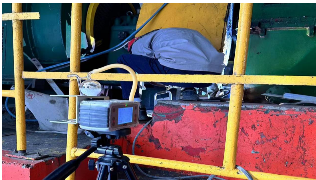
机修间（南厂区）电焊岗位
