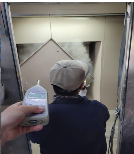
生产车间 2F 喷塑岗位
