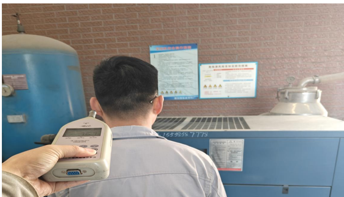
空压机区巡检岗位
