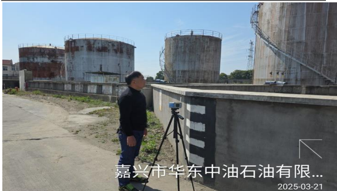
罐区巡检岗位
