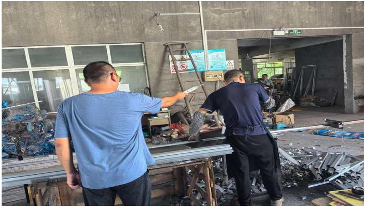
3F 车间切割岗位
