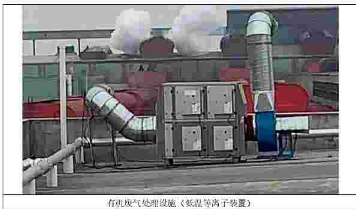
图 4-3 废气处理设施图
