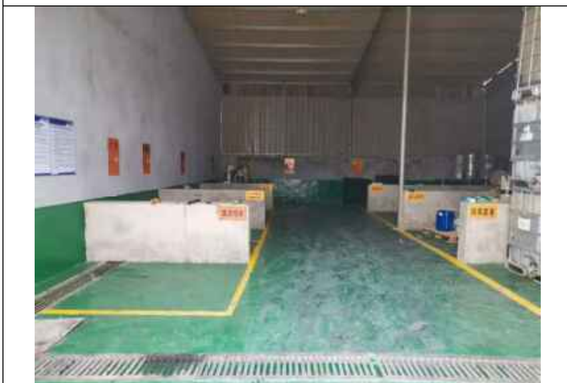
危废仓库内部
