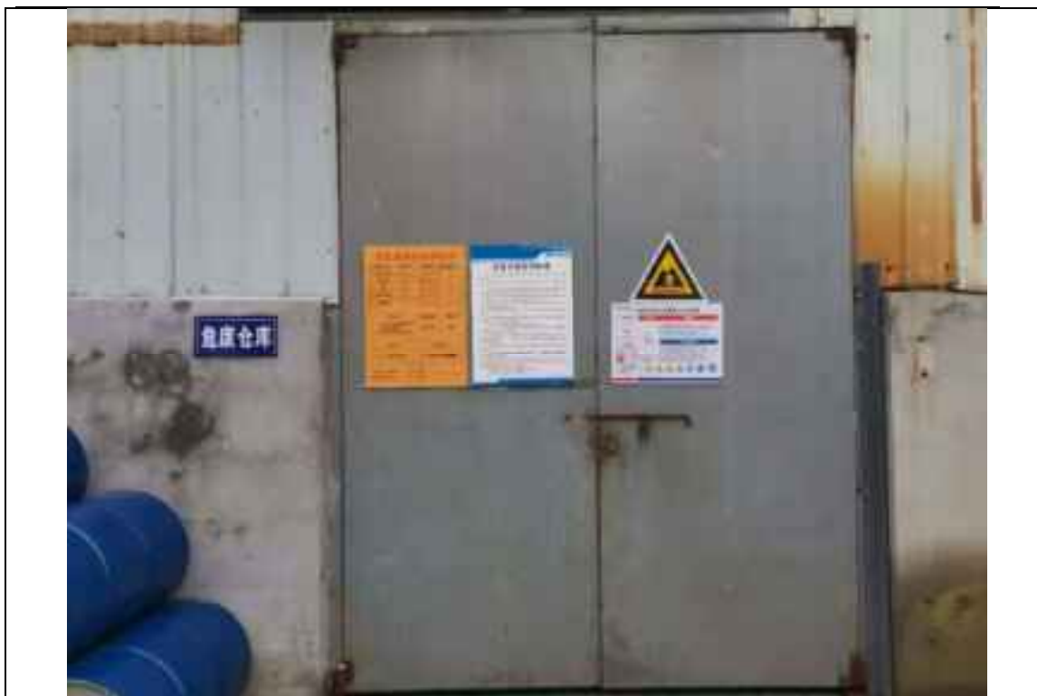
危废仓库外部照片
