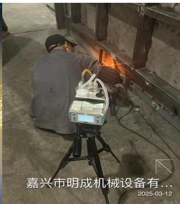
生产车间焊接岗位
