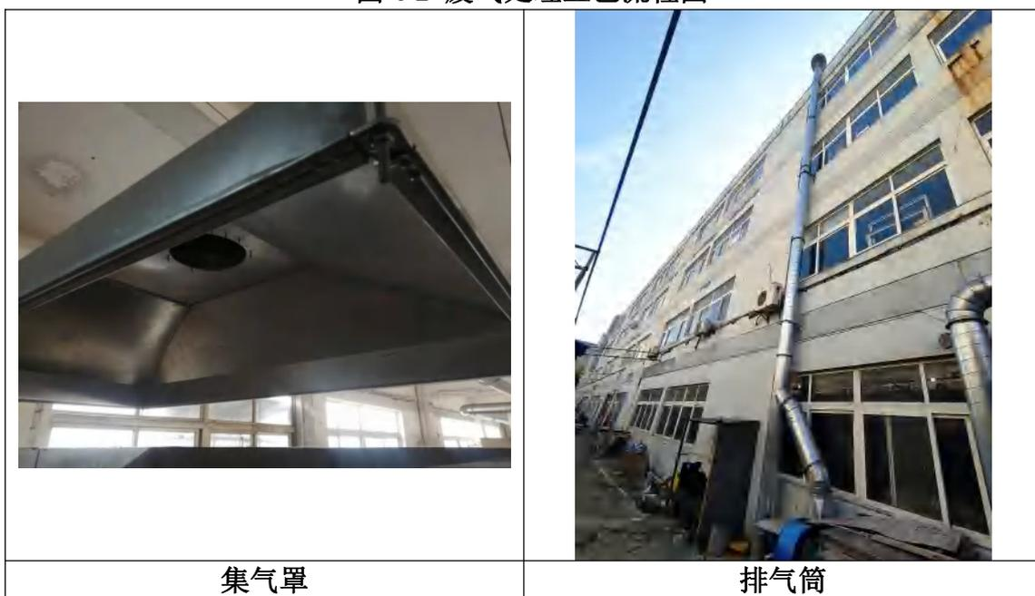
图 4-3 废气收集设施及排放口图
