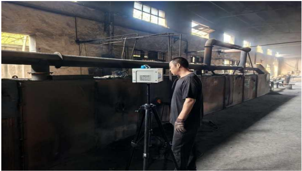
焚烧车间焚烧岗位
