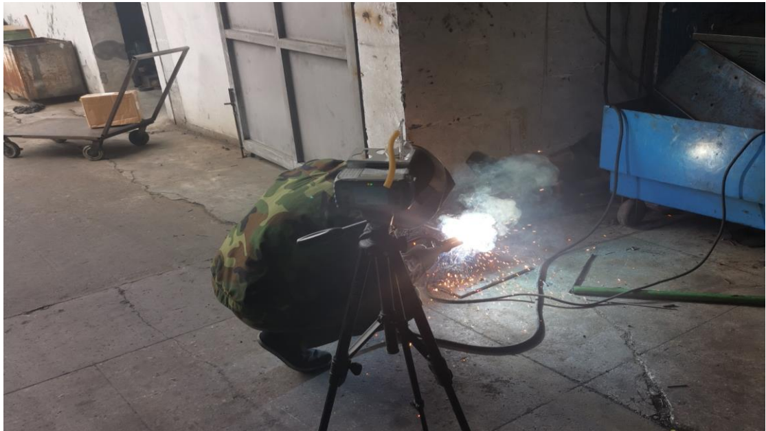
自动车间电焊岗位
