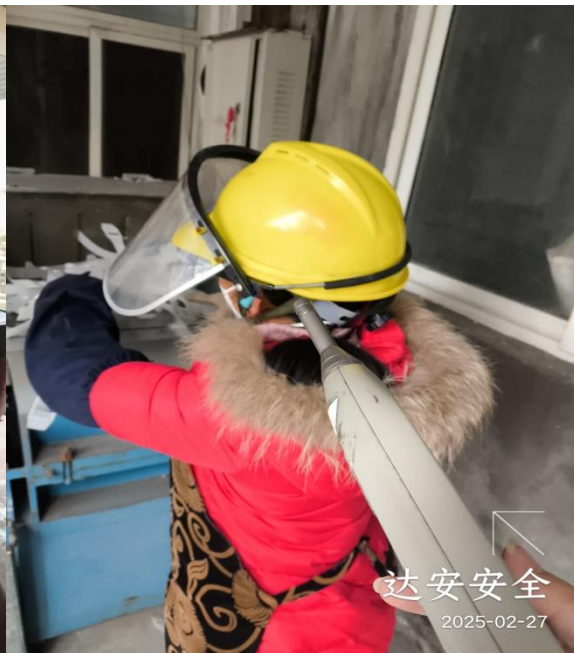
粉碎车间粉碎岗位
