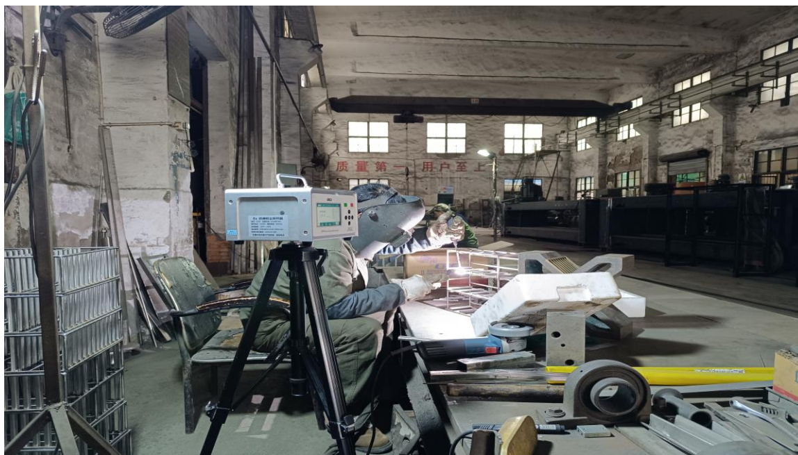
生产车间焊接岗位
