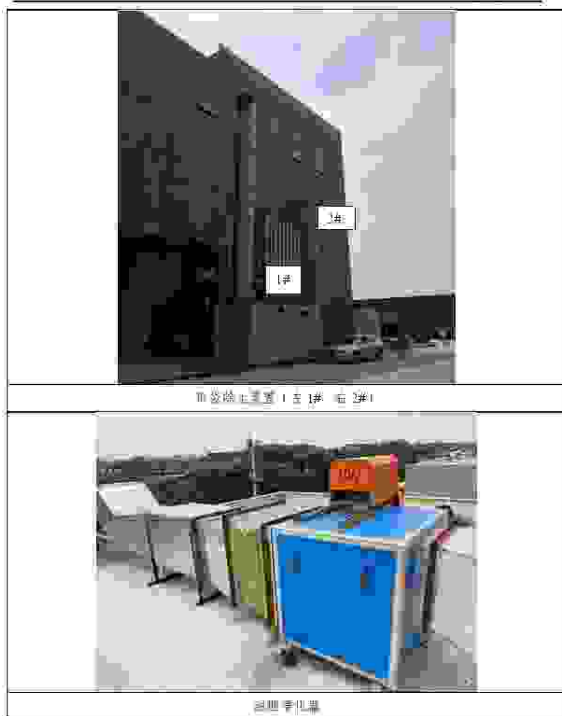
图 4-3 企业废气治理现场相关照片
