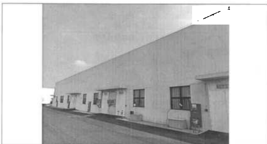
危废仓库外部照片
