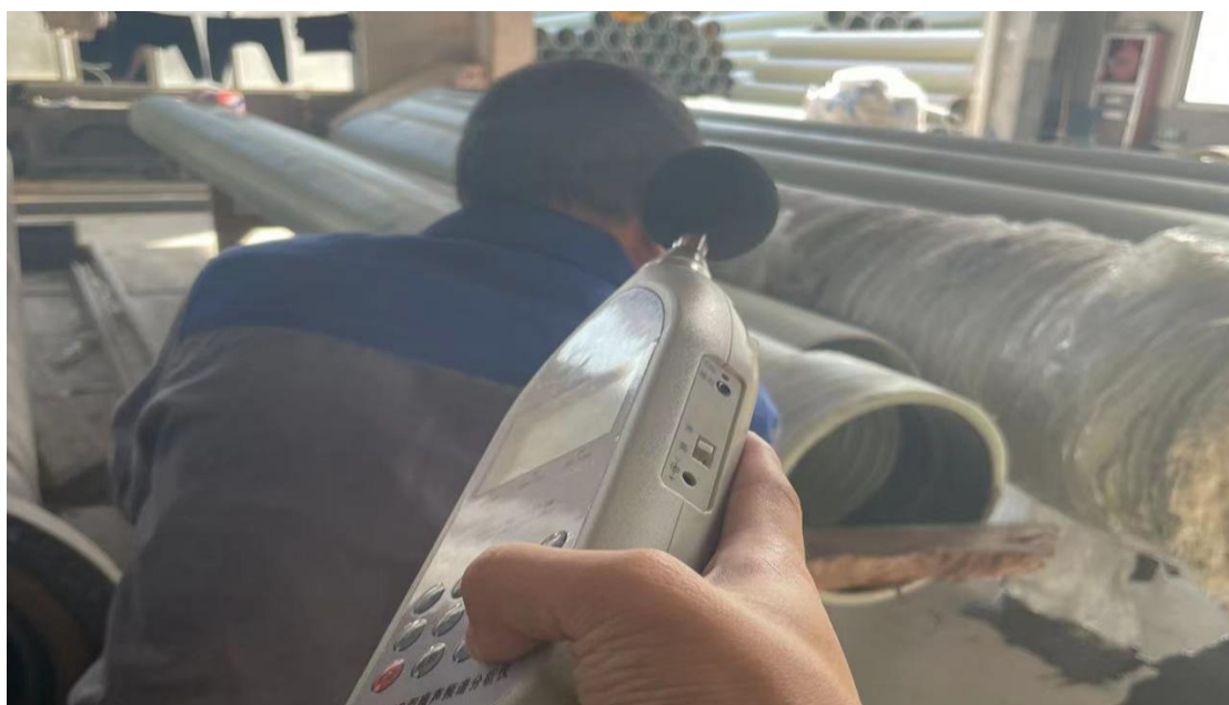
3 车间装接头岗位
