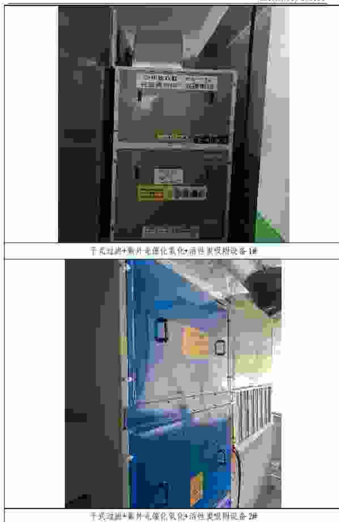
图 4-3 企业废气治理现场相关照片
