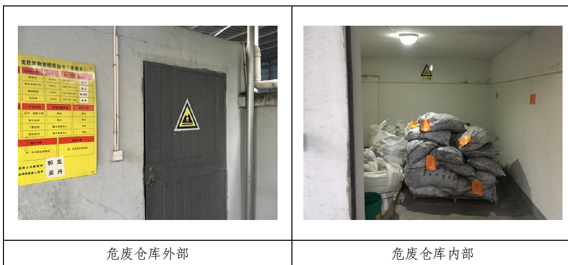
图 4-6 危废仓库现场照片
