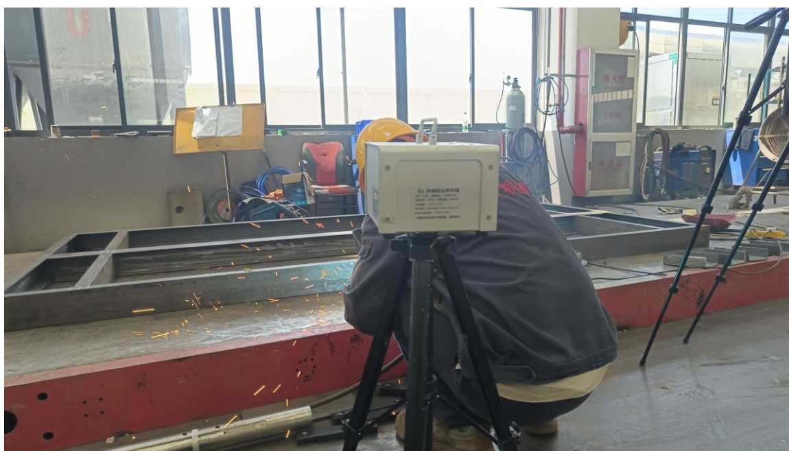
生产车间焊接岗位
