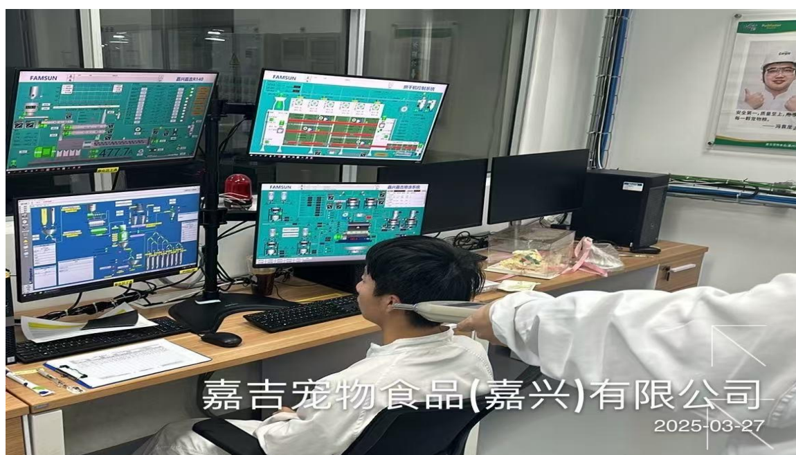
2F 膨化车间膨化控制室岗位
