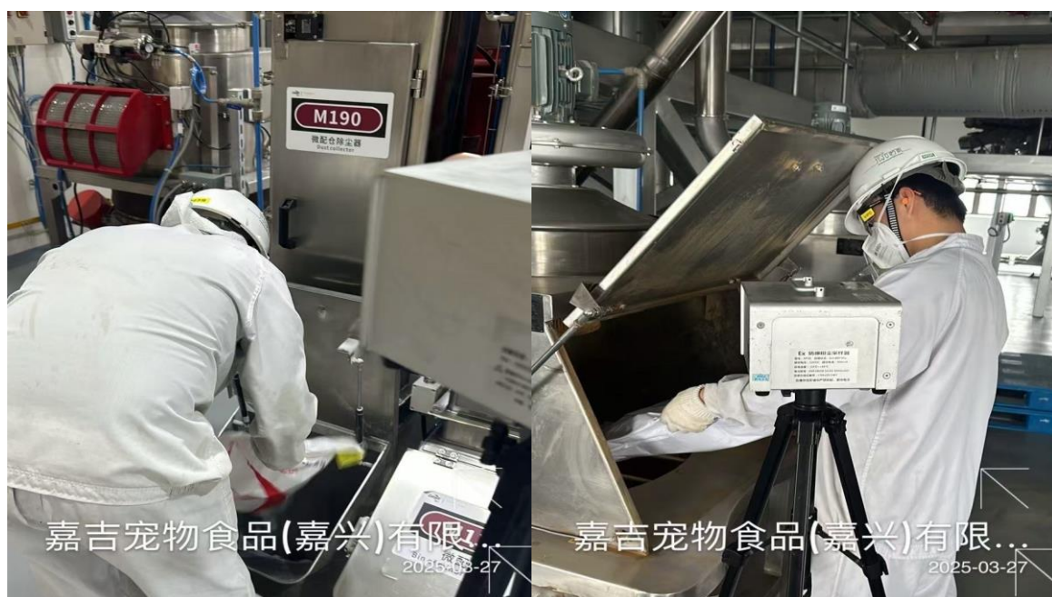
3F 预混配料车间投料岗位
