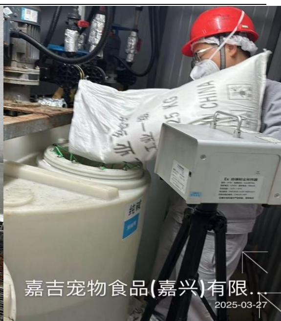
辅助单元污水站投料岗位
