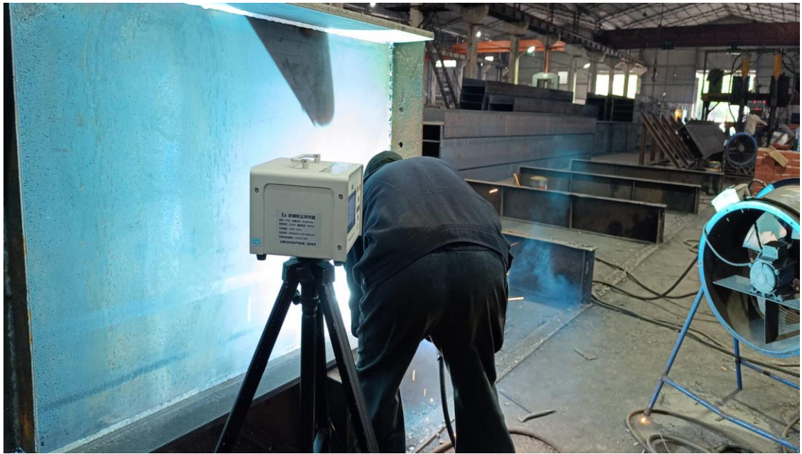
生产车间气保焊岗位
