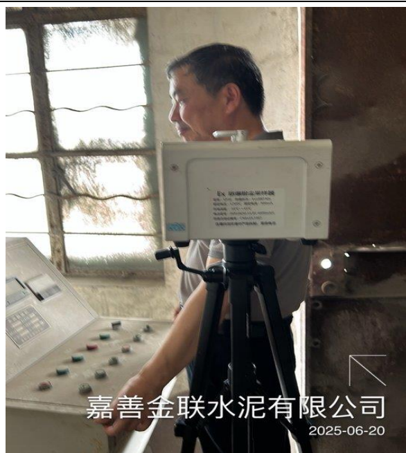
生产车间散装控制室岗位
