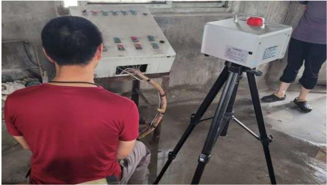
生产车间矿粉控制室岗位
