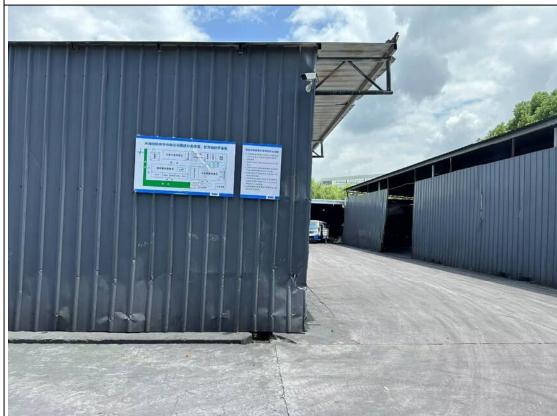
一般固废仓库外部
