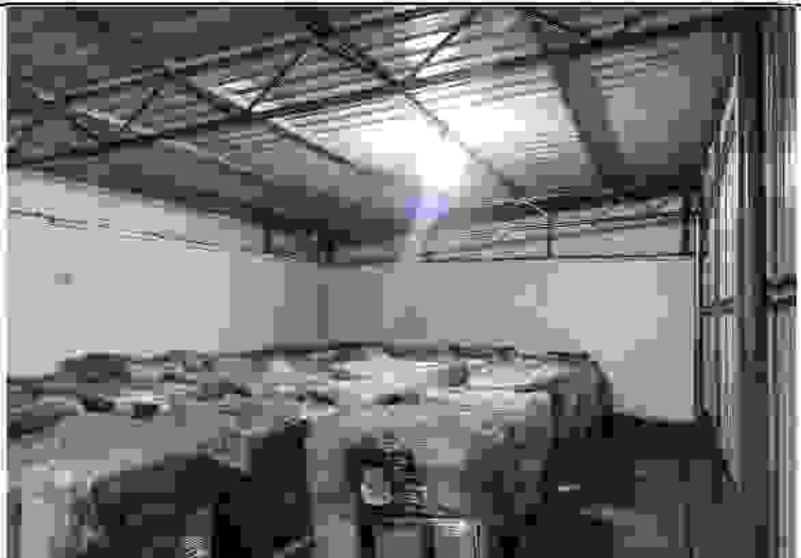
危废仓库内部
