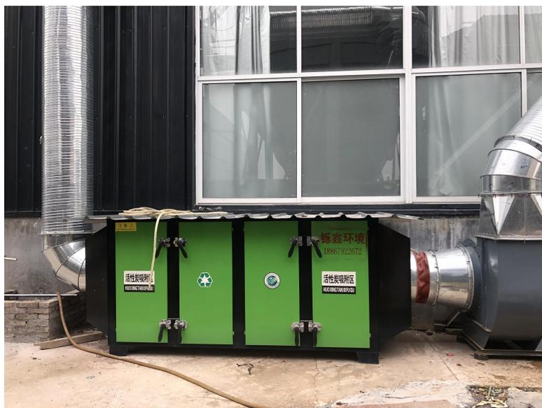
挤出、印刷废气处理设备
