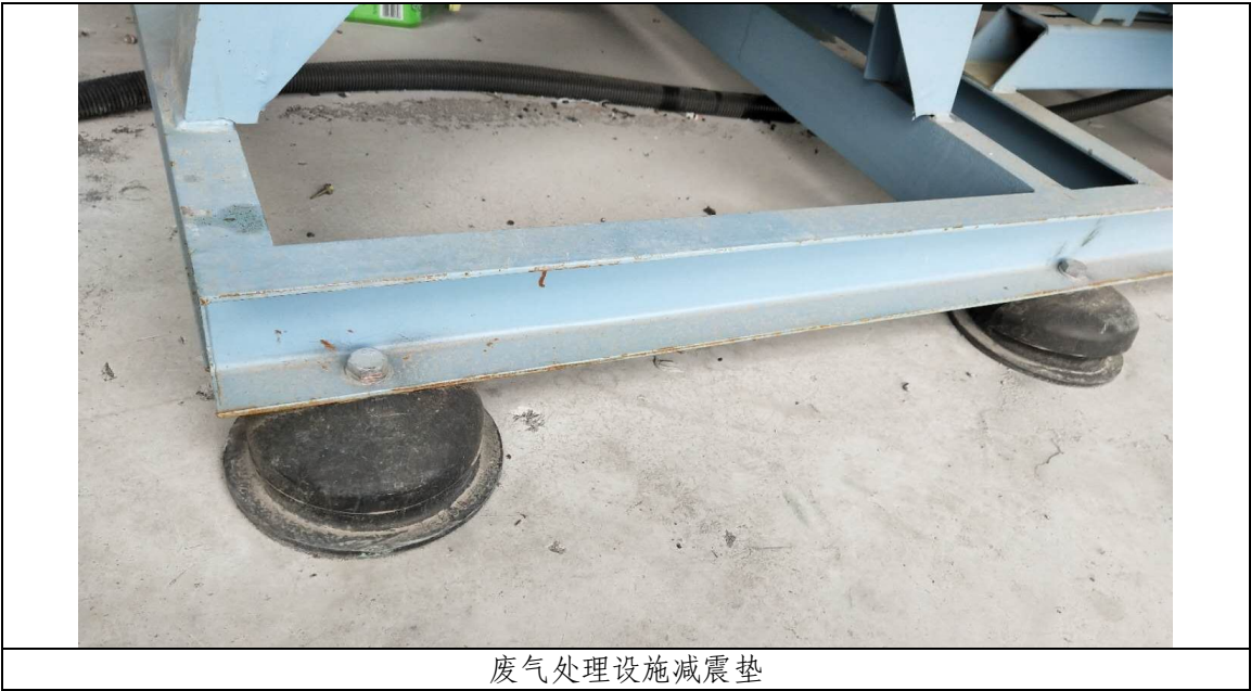
图 4-4 企业噪声治理措施现场相关照片
