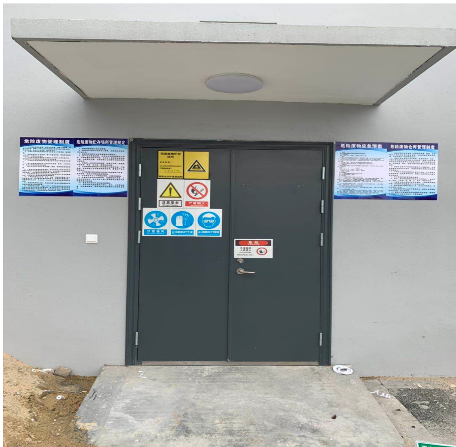
危废仓库外部
