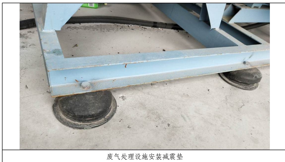
图 4-4 企业噪声治理措施现场相关照片
