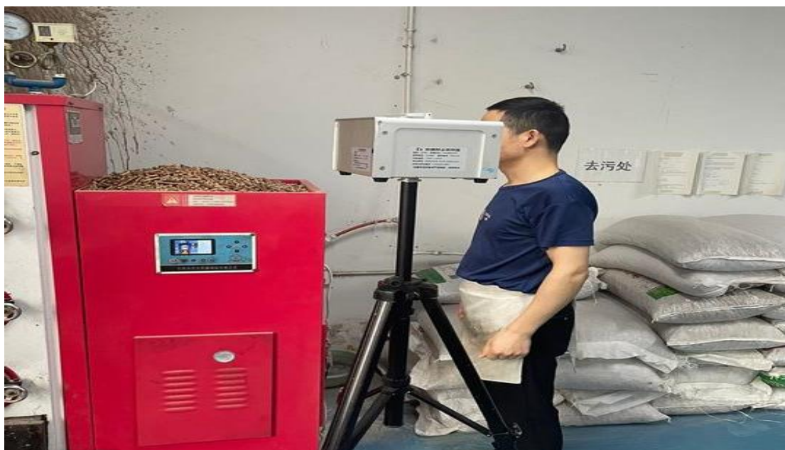
生产车间锅炉岗位
