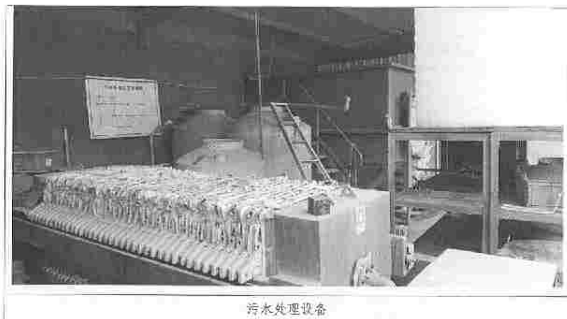
图 4-2 企业废水治理现场相关照片
