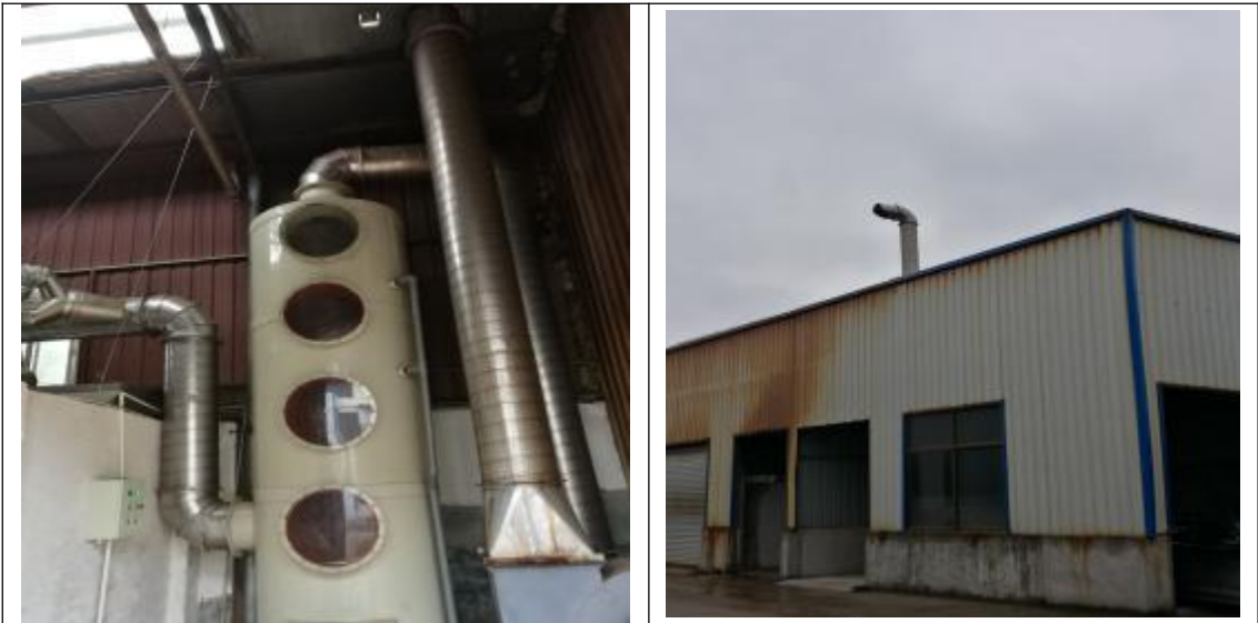
图 4-4 企业废气治理现场相关照片
