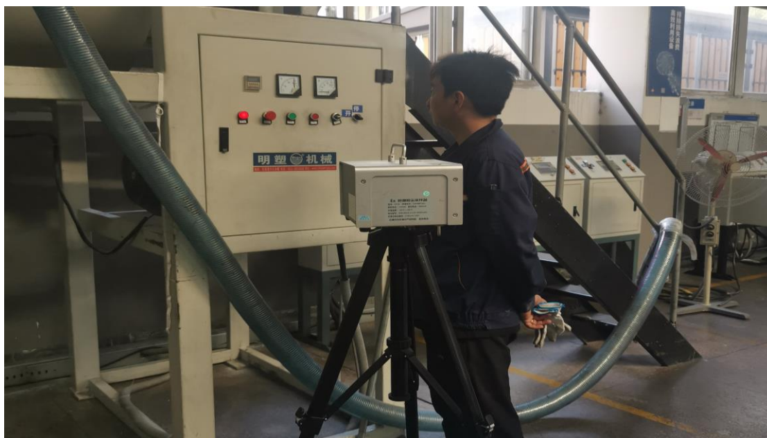
磨粉车间混料岗位
