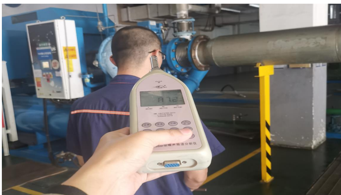
空压站巡检岗位
