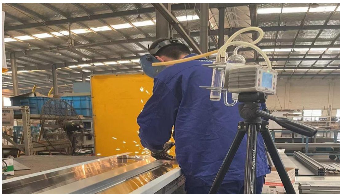
钣金车间 1 氩弧焊岗位
