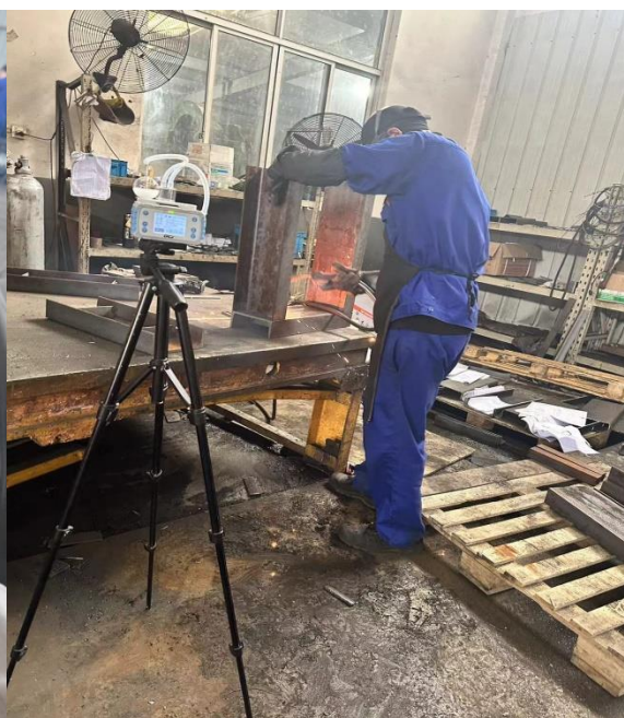
型材车间电焊岗位
