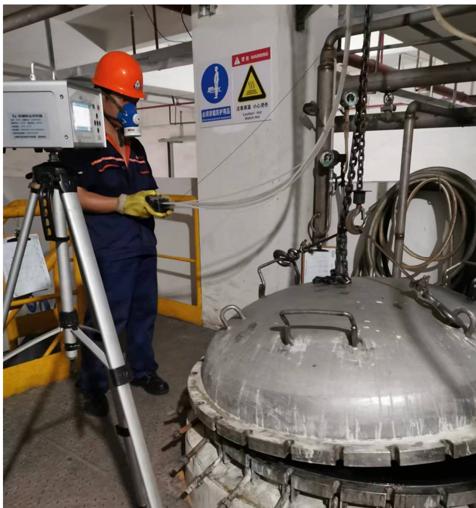
碱液清洗岗位
